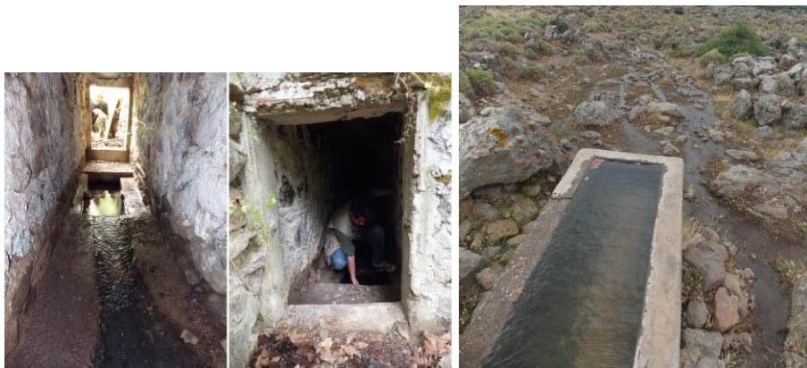
Εικόνα 17: Καλλιέργεια πηγής και παροχή νερού για τα θηράματα στη Λέσβο (φωτογραφίες Φώτω Κόνσολα, έργο του Κ.Σ. Καλλονής)
